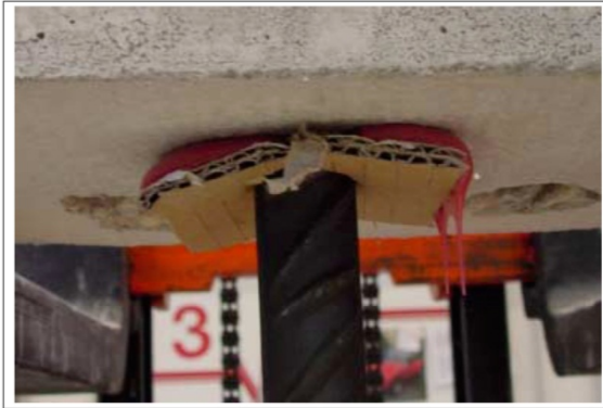
圖9 使用瓦楞紙防止溢流
