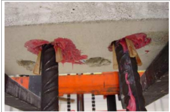
圖10 使用楔型木片固定鋼筋
