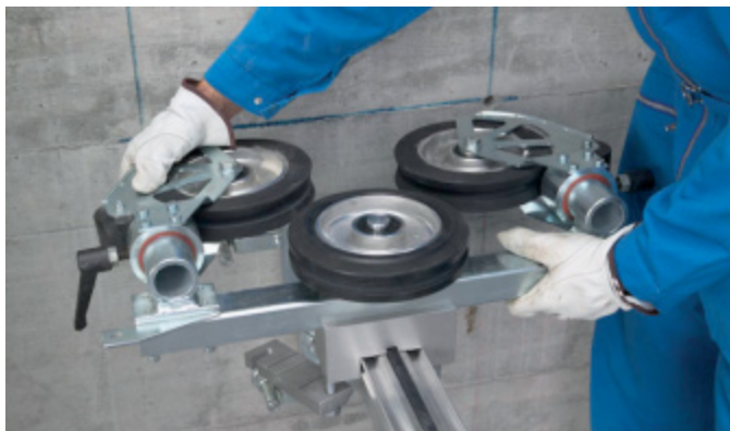
Wieldrager opzetten (let op de afstand tot de muur)
