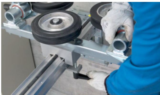
Bevestigingselement sluiten en spanhefboom vastdraaien.
